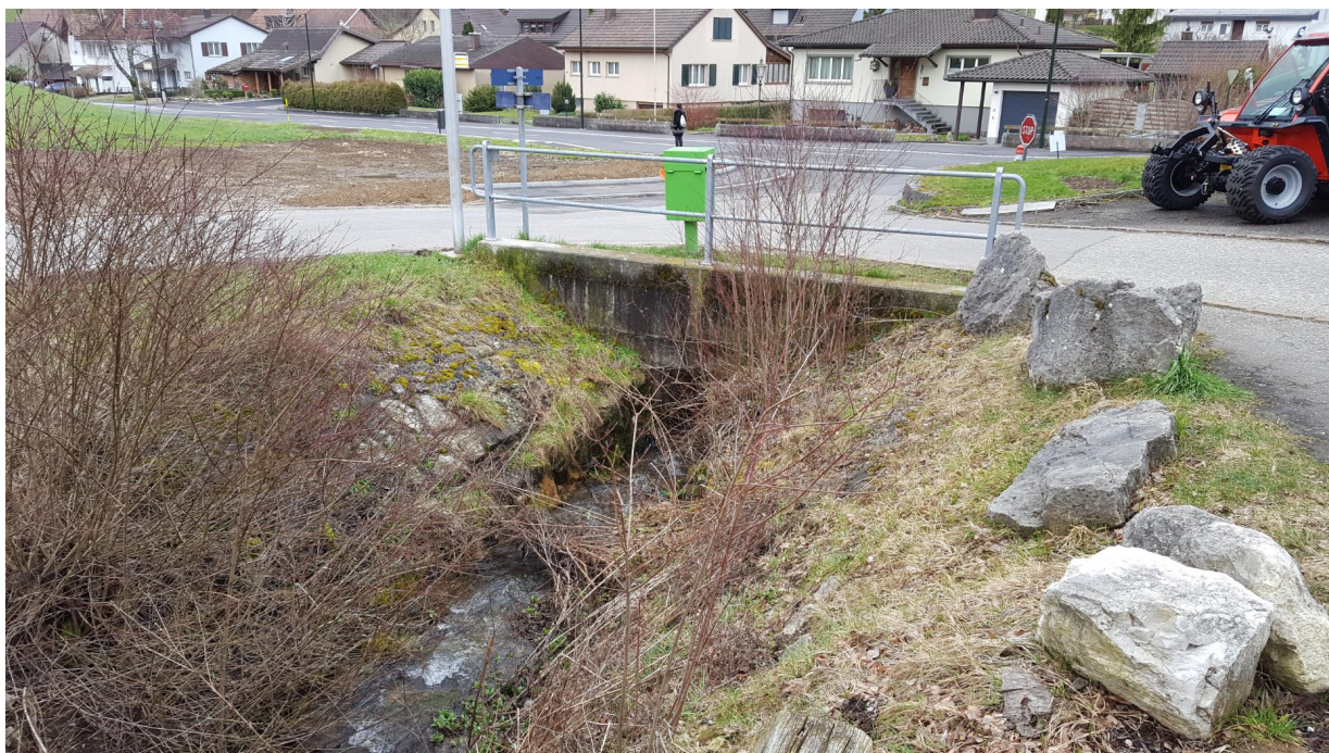
Abbildung 1: Beginn des kurzen eingedolten Abschnitts vor der Hauptstrasse
